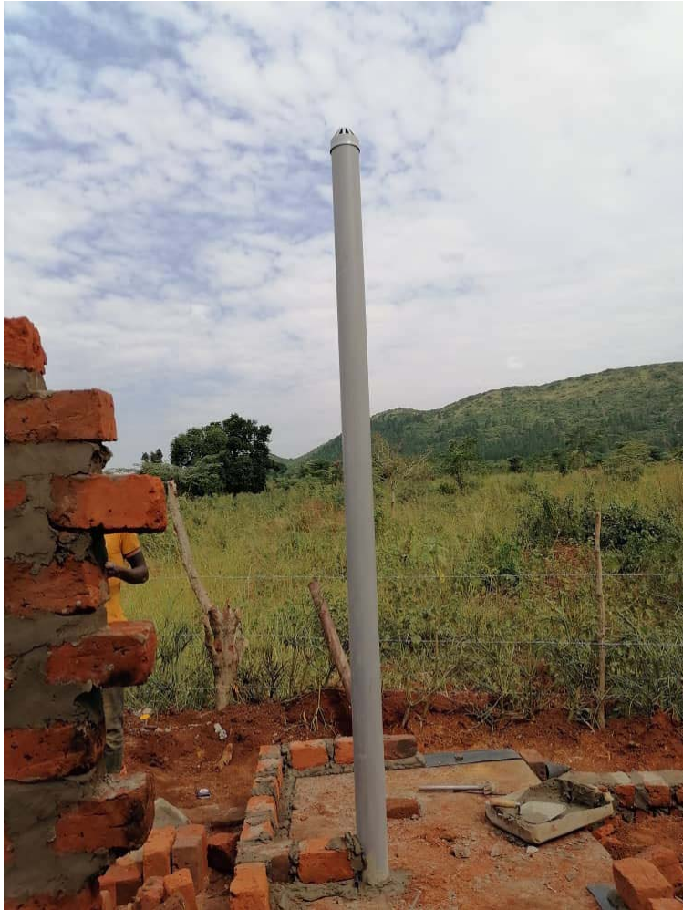
Das Abgasrohr zur Ableitung der Faulgase.
