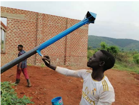
Letzter „Schliff“ für den Chimney (Schornstein)
