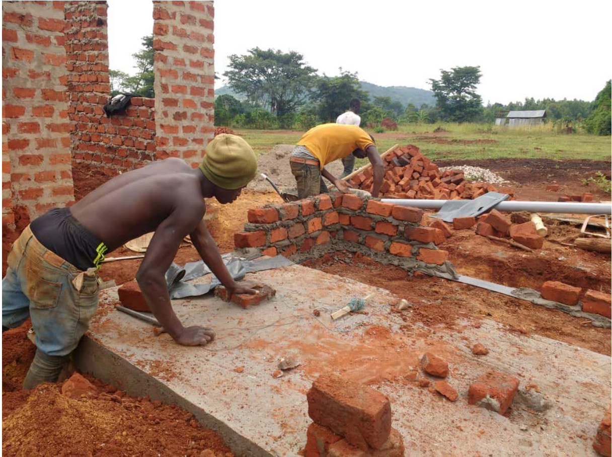
Um die Toiletten wird das Toilettengebäude gebaut.
