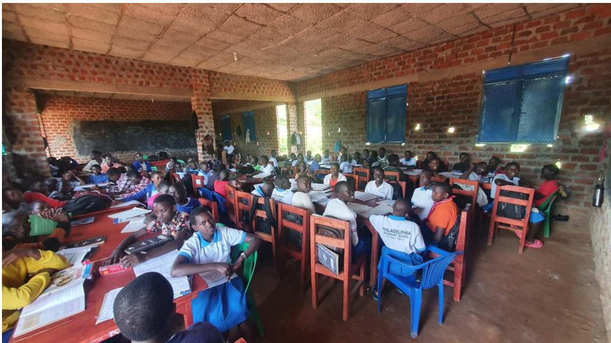
Neues Schulgebäude, der Innenausbau ist noch nicht abgeschlossen.
