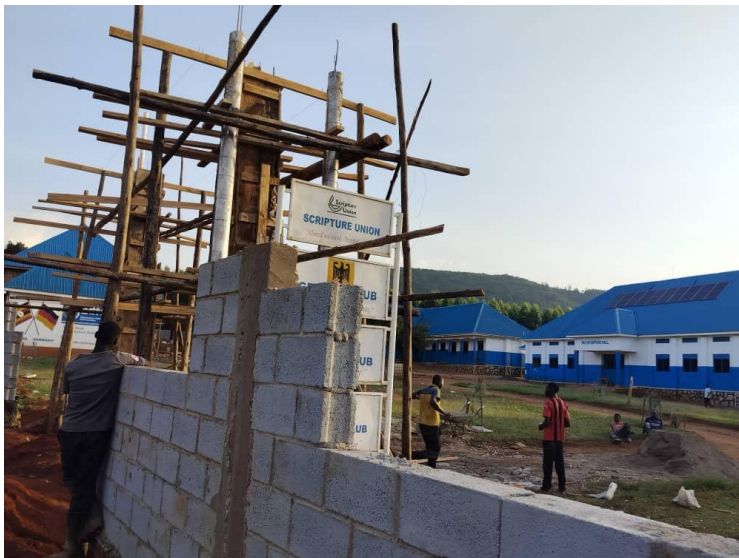
Bau des Zauns und Vorbereitung für das Tor
